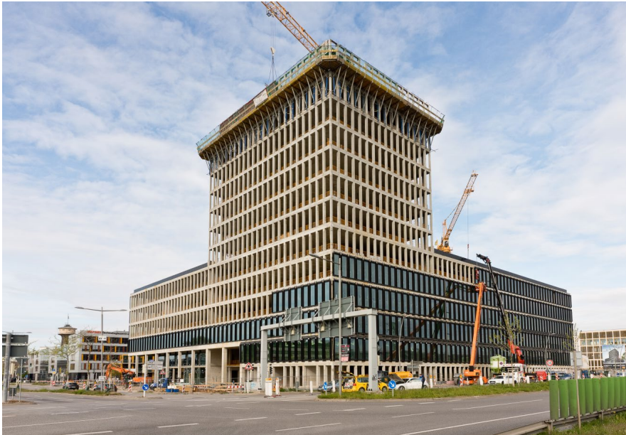
Bild 3: Blick von der Südtangente auf die Büroimmobilie LOKSITE im Mai 2022 (D&S / Thomas Raffler)
