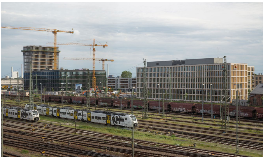
Bild 2: Blick vom Busbahnhof Mannheim auf die beiden Büroimmobilien LOKSITE und LIV. (Joachim Tremmel, D&S)
