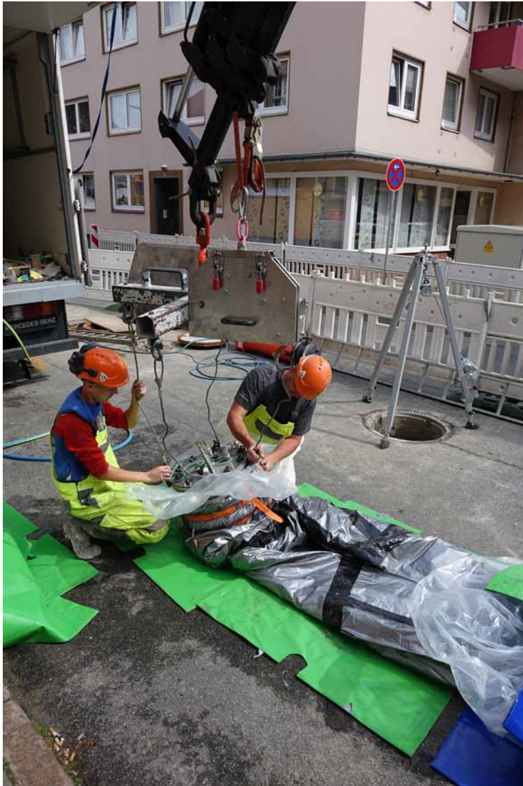
Vorbereitung des Vertiliners® für den Einbau.
