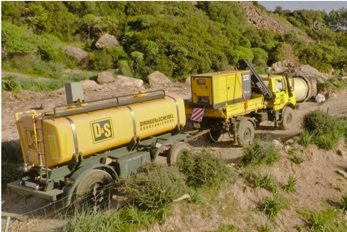
Transport des Wassers für die Injektionsarbeiten.
